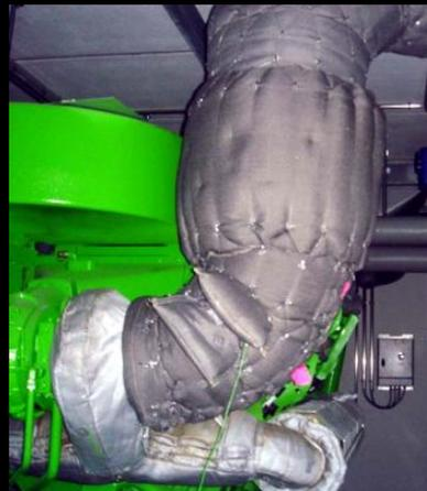
Verbrennungsmotoren werden im Betrieb **sehr heiß**. Diese Hitze ist jedoch für die Umgebung schädlich, hier gilt es, die Umgebung vor der **Hitze zu schützen**. Hierfür gibt es eine perfekte Lösung: **Textile Isoliersysteme** gefertigt aus Original-TECHNO-Matratzen, alles **"Made in Germany"**.
